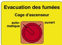
Figure 2: Interrupteur de commande des clapets d'aération dans la cage d'ascenseur ou dans le local des machines. Il est important que les inscriptions soient parfaitement lisibles. L'interrupteur rotatif peut être remplacé par un interrupteur à clé destiné aux pompiers.
