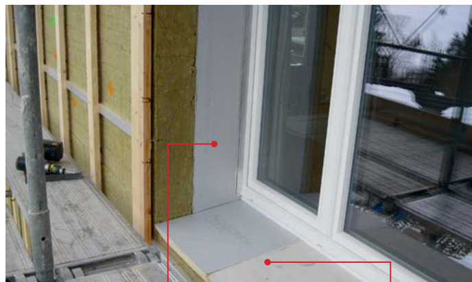
seitliche Leibungsdämmung
