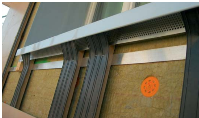
seitliche Leibungsdämmung
