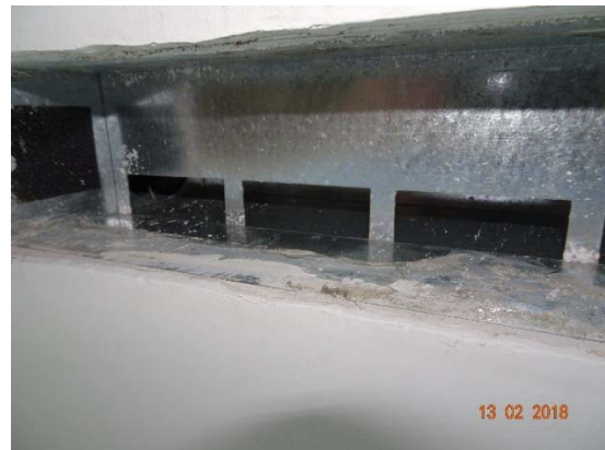
Abbildung 106: WNG ID 510: AUL-Eintritt in Gehäuse
