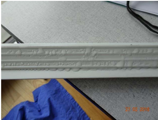
Abbildung 145: WNG ID 710: Kondensat an ZUL-El.
