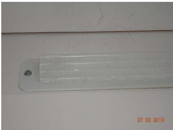
Abbildung 154: WNG ID 720: Kondensat an ZUL-EI.
