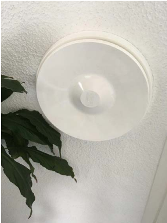
Abbildung 213: WNG ID 920: Zuluft eintritt
