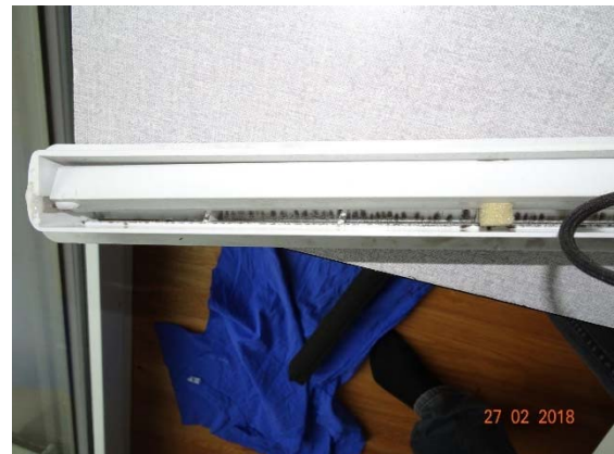
Abbildung 148: WNG ID 710: Ablagerung an ZUL-El.
