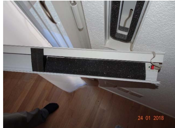
Abbildung 128: WNG ID 610: Luftführungselemente
