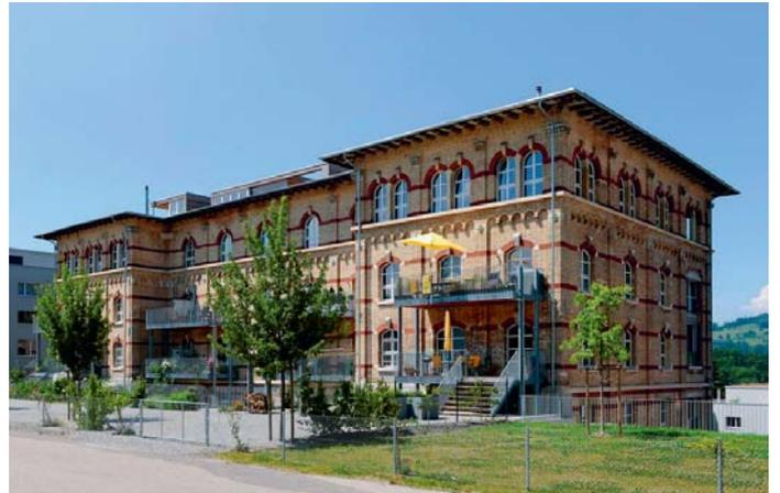
Bei der Sanierung wurde besonderes Augenmerk auf einen sorgfältigen Umgang mit der vorhandenen Struktur gelegt. Durch massvolle Reparaturarbeiten an den Aussenwänden konnten die denkmalpflegerischen Werte erhalten werden. Die zusätzlichen Balkone wurden als gestalterische Elemente integriert.
